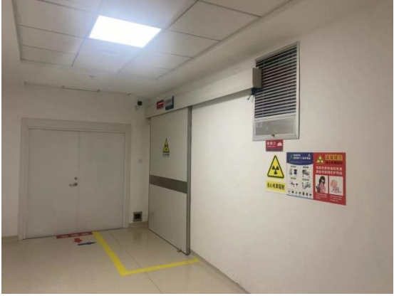
图4-2 门灯联锁、警戒线、工作指示灯及制度上墙
